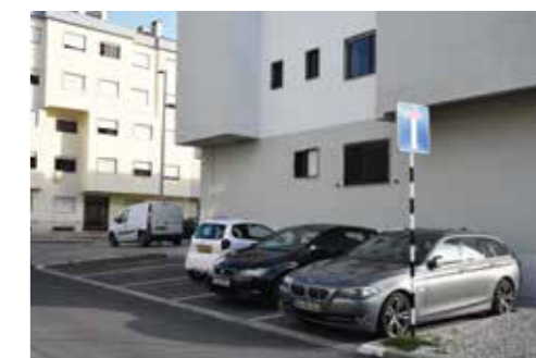
Requalificação Rua Mário Sá Carneiro
