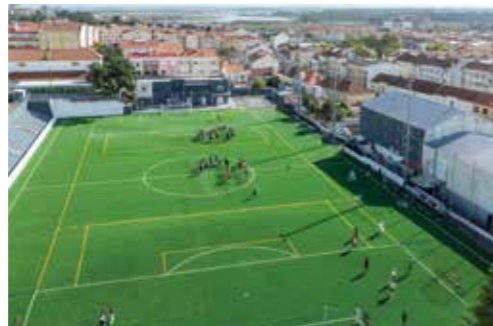
Requalificação Complexo Ginásio Clube Corroios
