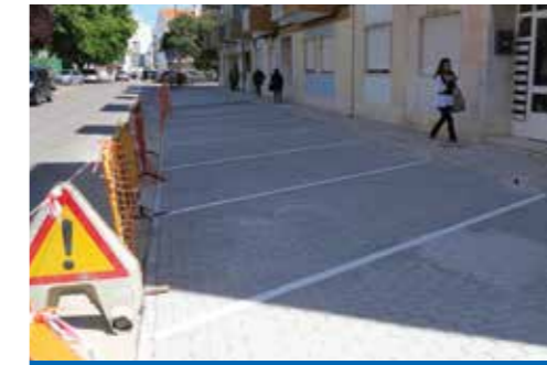
Requalificação Rua Cidade do Porto
