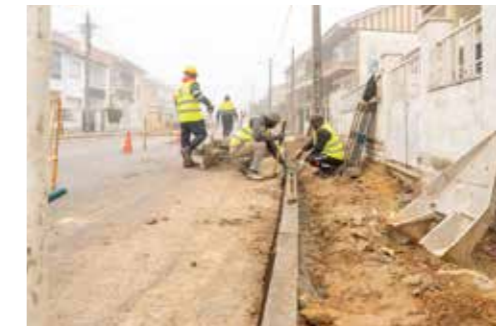
Nova Rede Abastecimento Água Vale Milhaços
