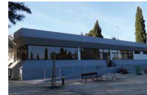
Nova Capela Cemitério Corroios
